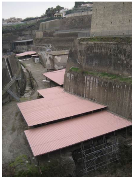
Figg. 5 - 6: coperture provvisorie nell'area "Scavi Nuovi" (archivio Studio Pesaresi per HCP – 2010)
