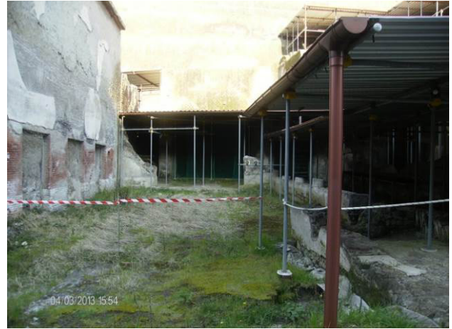
Figg. 19-20: i diversi livelli del complesso che costituisce la Casa dei Rilievi (lato est Terme Suburbane); nella seconda foto, gli appoggi dei tubi da ponteggio direttamente sui ritrovamenti archeologici (archivio Studio Pesaresi per HCP – 2015)
