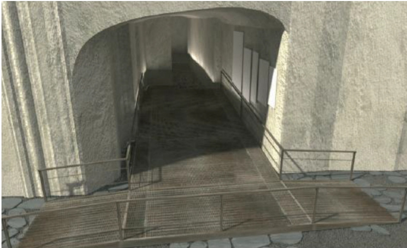
Fig. 25: sbarco della rampa Martuscello alla spiaggia antica con rampa compatibile con sedie a ruote.
