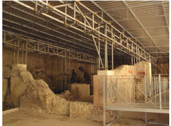
Figg. 15-16: vedute dall'esterno e dall'interno della copertura di Villa dei Papiri su struttura a traliccio in tubo-giunto (archivio Studio Pesaresi per HCP – 2013)
