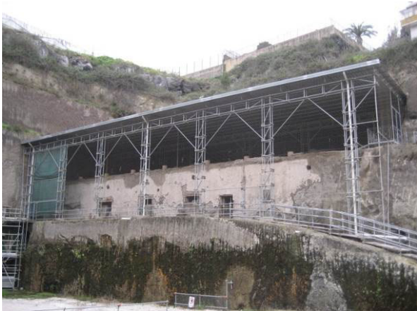
Figg. 15-16: vedute dall'esterno e dall'interno della copertura di Villa dei Papiri su struttura a traliccio in tubo-giunto (archivio Studio Pesaresi per HCP – 2013)
