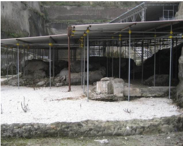
Figg. 5 - 6: coperture provvisorie nell'area "Scavi Nuovi" (archivio Studio Pesaresi per HCP – 2010)
