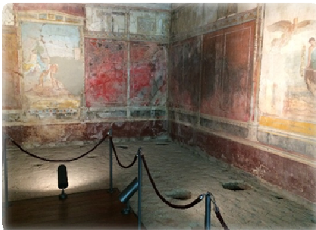
Fig. 28: Parco Archeologico di Pompei. Complesso delle domus di Championnet. Elementi metallici reversibili con piano di calpestio in moduli di materiale poltruso
