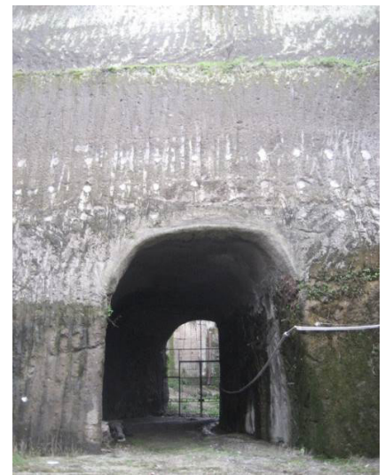
Fig. 11-14: vedute dei fronti di scavo; nell'ultima foto il tunnel di collegamento all'Antica Spiaggia (archivio Studio Pesaresi per HCP – 2010/2013)
