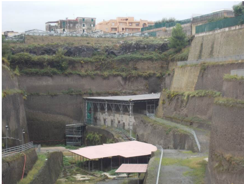
Fig. 9: verticalità dei fronti di scavo nell'area "Scavi Nuovi" (archivio Studio Pesaresi per HCP – 2015)
