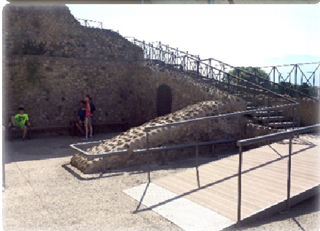
Fig. 29: Parco Archeologico di Pompei. Antiquarium e Villa Imperiale. Elementi metallici reversibili con piano di calpestio in doghe di legno tecnico.
