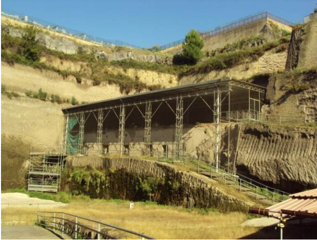
Fig. 3: la copertura provvisoria della Villa (archivio Studio Pesaresi per HCP – 2009)
