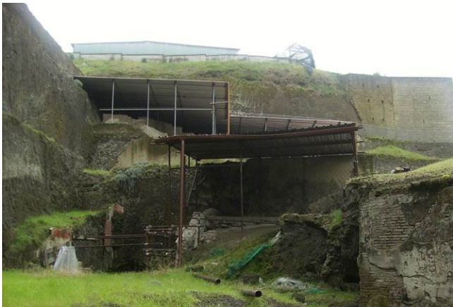
Figg. 21-22: il sistema di raccolta delle acque piovane, costituito da gronde e pluviali in plastica, non convoglia le stesse in adeguate canalizzazioni (archivio Studio Pesaresi per HCP – 2015)
